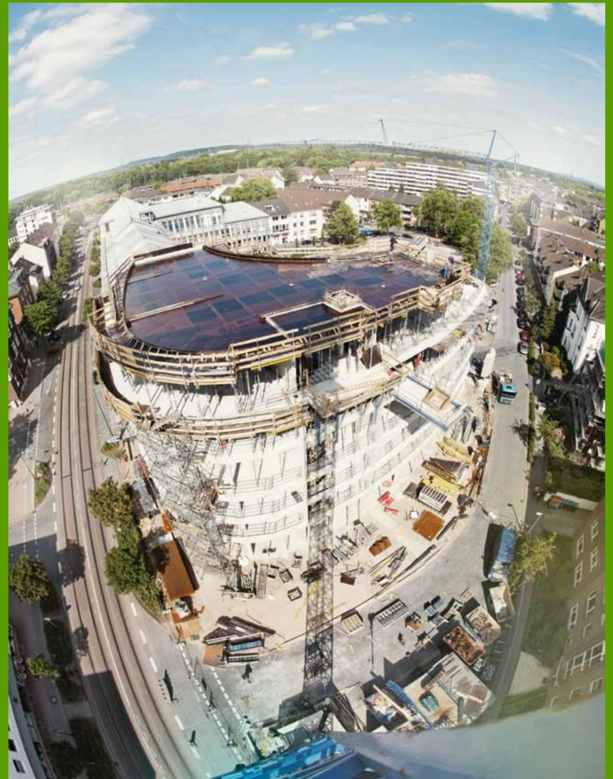
Einen „Grundstein für die Zukunft“ legt die Sparkasse Dinslaken-Voerde-Hünxe mit ihrem neuen Geschäftsgebäude. Der als Passivhaus konzipierte Bau ruht auf 39 Betonpfählen von jeweils 15 Meter Länge, die die Stabilität des Gebäudes sichern und zusätzlich ca. 20.000 Kubikmeter Erdreich thermisch erschließen. Die Fertigstellung des modernen Neubaus im Herzen von Dinslaken wird voraussichtlich zum Ende des Jahres 2011 erfolgen.
